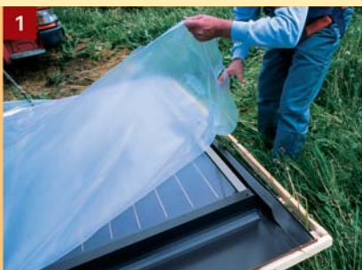
1 Atașați funia în dispozitivele prevăzute, tăiați folia și despachetați panoul.
