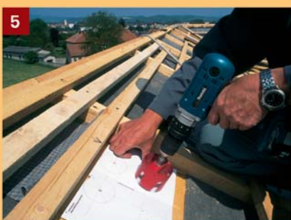
5 Începeți să faceți străpungerile cu ajutorul șabloanelor.
