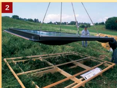
2 Demontați scheletul din lemn care este atașat panoului.
