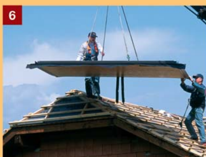
6 Colectorul este adus pe acoperiș în poziție orizontală.
