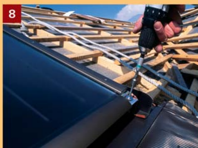
8 Înșurubarea colectorului.
