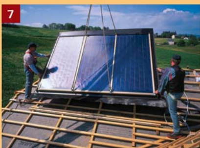
7 Înainte de a fi așezat pe acoperiș, panoul trebuie adus într-o poziție oblică, mai înclinată cu aproximativ 10° decât înclinația acoperișului.
